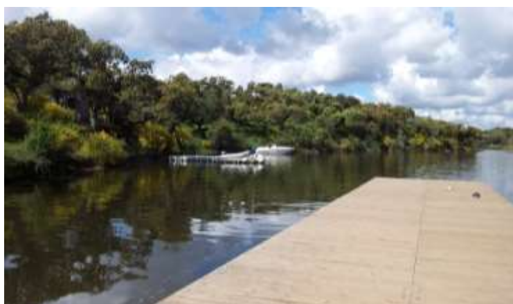
Figura 66 – Cais da Herdade da Cortesia
